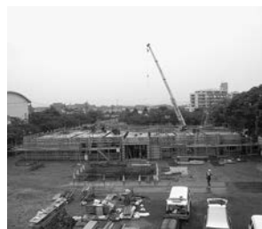
▲建設中の新図書館
