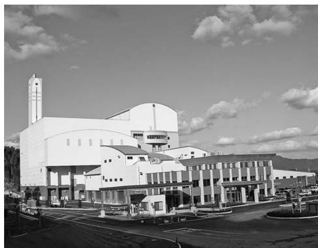
▲筑紫野市、小郡市、基山町による共同運営ごみ処理施設(クリーンヒル宝満)
