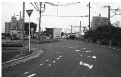
▲路面標示の止まれや停止線等が消えている町道
