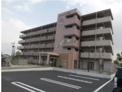
PFI事業建設の住宅
