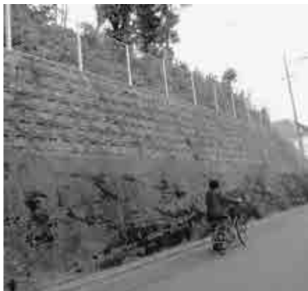
▲若宮八幡宮東側の法面
