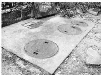
▲合併処理浄化槽
