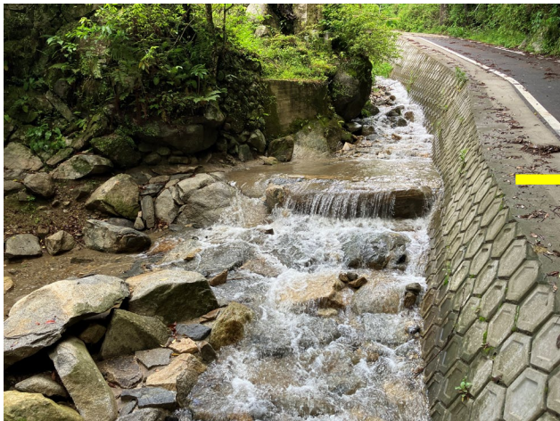
水門北側（水門取水部）堰復旧完了
