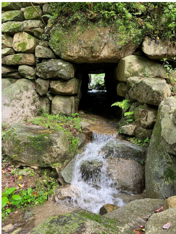
水門南側 流水復旧
